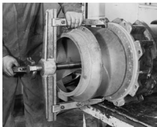
Рис. 9.2. Демонтаж рабочего колеса с помощью съемника
